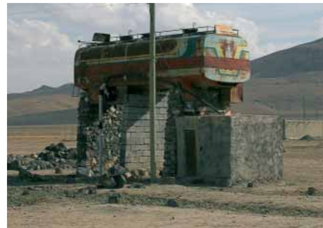
A kopár részeken kiszuperált tankerek tartályaiban tárolják a fűrt kútból származó ivóvizet
