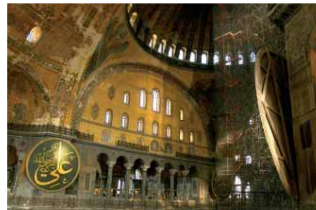
Felújítás alatt a hatodik században épített Hagia Sofia
